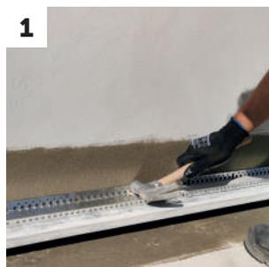
1 Fixação perfil de arranque e impermeabilização do suporte.
