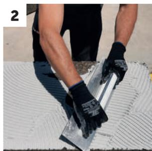
2 Colocação de **ISOVIT E-CORK** no tardo dos painéis pelo método de colagem contínua
