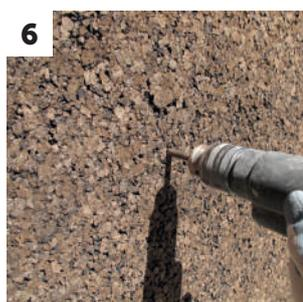
6 Realização dos furos para a colocação da fixação mecânica
