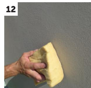
12 Eponjamento da superfície para obtenção do acabamento areado fino
