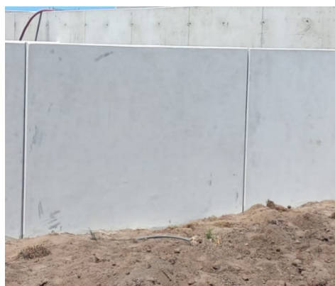
Aspetto final após aplicação do B-REPARA K PLUS .
