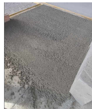
Acabamento talochado do PLAN LIGHT EPS .
