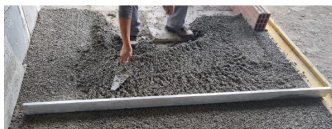
Regularização do pavimento com régua metálica.
