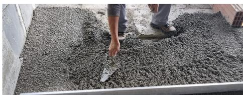
Nivelación del suelo con una regla metálica.
