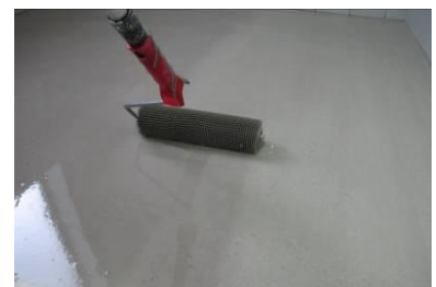
Uniformizar la superficie c/ rodillo aireado
