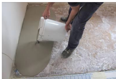
Aplicación de PLAN LEVEL 315
