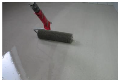
Uniformização da superfície c/ rolo de bicos
