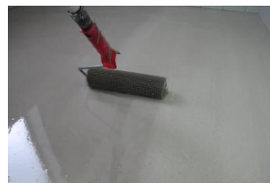
Uniformização da superfície c/ rolo de bicos
