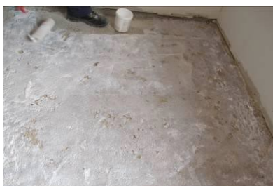
Aplicación de imprimación MICROART AD 21
