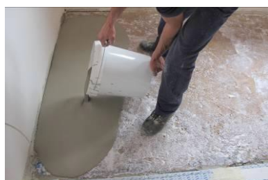
Aplicación de PLAN LEVEL 15/40
