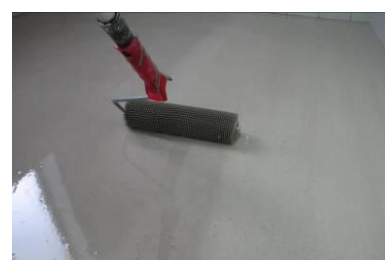
Uniformizar la superficie con un rodillo
