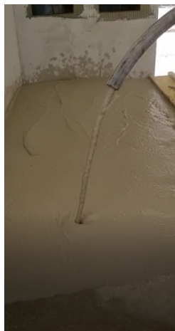
Aplicação do PLAN FLUID
