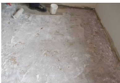
Aplicação do primário MICROART AD 21
