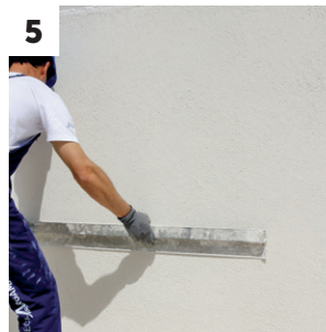
5 Regularização e aperto do ISODUR ONE
