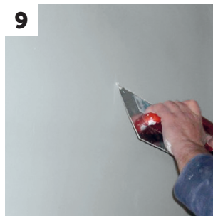
9 Sistema ISODUR LISO – Aplicação das camadas sucessivas de REDUR PK 06 após lixagem entre camadas, apenas em interiores
