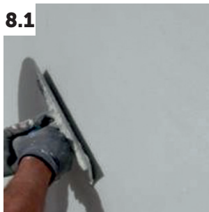
8.1 Sistema ISODUR LISO – Aplicação da primeira camada de REDUR PK 02 sobre ISOVIT FIBRAFLEX seco
