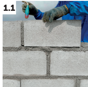
1.1 Obra nova – Suporte em alvenaria de bloco térmico
