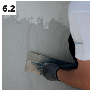
6.2 Sistema de ISODUR AREADO – – Aplicação da primeira camada de ISODUR PK FLEX
