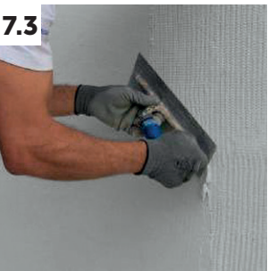
7.3 Sistema ISODUR LISO/ ACRÍLICO – Aplicação da segunda camada de ISOVIT FIBRAFLEX
