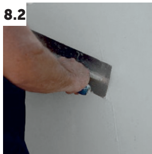
8.2 Sistema ISODUR LISO – Camadas sucessivas de REDUR PK 02 após lixagem entre camadas
