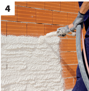
4 Projeção do reboco térmico ISODUR ONE
