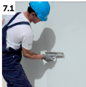
7.1 Sistema ISODUR LISO/ ACRÍLICO – Primeiro barramento de ISOVIT FIBRAFLEX
