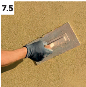
7.5 Sistema ISODUR ACRÍLICO – Aplicação do acabamento acrílico colorido ISOVIT REV
