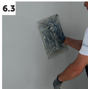
6.3 Sistema de ISODUR AREADO – Talochamento da superfície final de ISODUR PK FLEX para receber o esponjamento e esquema de pintura.
