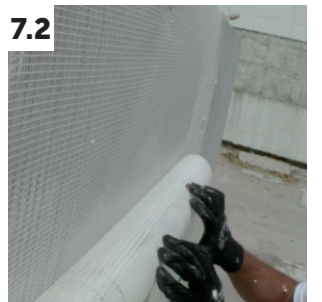
7.2 Sistema ISODUR LISO/ ACRÍLICO – Incorporação da rede no ISOVIT FIBRAFLEX
