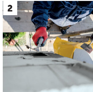
2 Reabilitação de alvenaria de pedra – Consolidação com REABILITA CALCS
