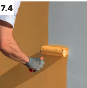
7.4 Sistema ISODUR ACRÍLICO – Aplicação do primário ISOVIT AD 20
