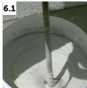
6.1 Sistema ISODUR AREADO – Amassadura do ISODUR PK FLEX
