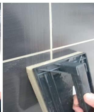
Nettoyage du surplus de mortier
