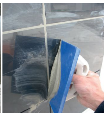
Jointoiment avec ADHERE Cor 312
