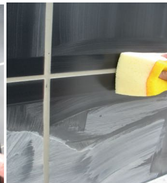
Nettoyage du surplus de mortier
