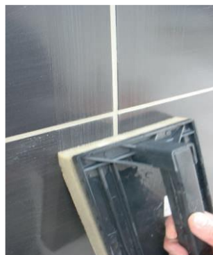
Limpieza del exceso de mortero
