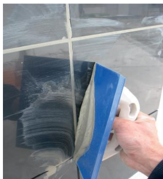
Rejuntado con ADHERE Cor 312
