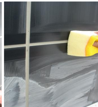
Limpieza del exceso de mortero
